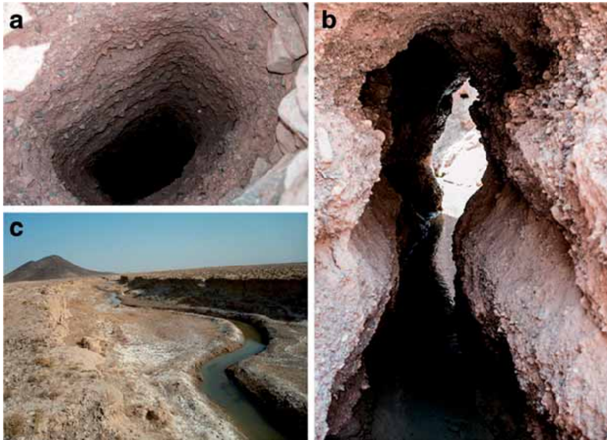
شکل ۲-۸ (a-c): مثالهایی از کاریز در ولایات هرات و فراه. a: چاه تهویه سر باز که در عمق آن کمی آب دیده می شود (ولایت هرات). b: تونل کاریز بین دو چاه تهویه در نزدیکی مخرج کاریز (ولایت فراه). c: کانالی که آب کاریز را به کشتزار انتقال می دهد (ولایت فراه) و به دو طرفه آن قشر نازک نمک دیده می شود که بر اثر عملیه تیخیر به وجود آمده [۱].
