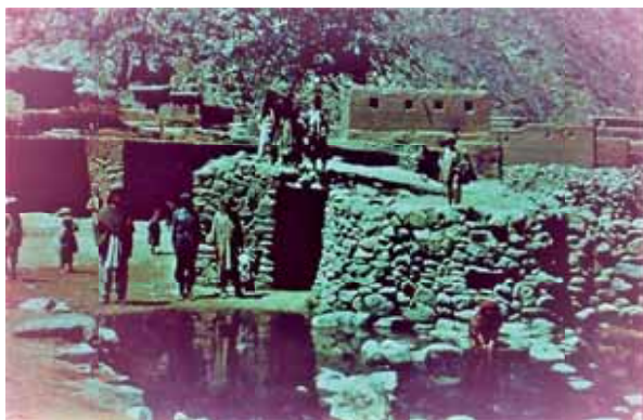
شکل ۲-۱۰: دهانه کاریز با حوض ذخیره در دشت توپ شمالی (تصویر: روستائی).
