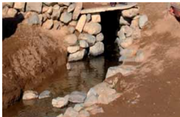
شکل ۲-۹: دهانه کاریز که قسماً سنگ کاری شده [۴۱].
